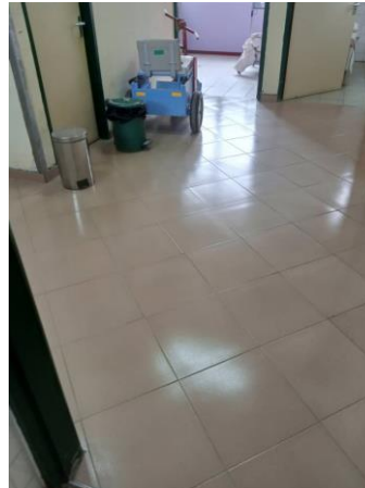
Plattenboden- einfacher im Unterhalt im heiss-feuchten Klima und verbesserte Hygiene
